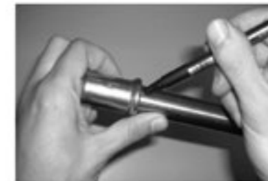
Обозначьте на трубе глубину ввода. Mark the tube as a reference point.
